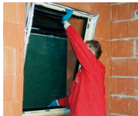
Einrichten des Fensterrahmens
