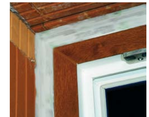
Bauanschlussfolie an das Mauerwerk kleben – es folgen Verputzarbeiten
