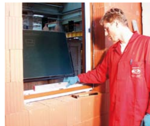
Nach dem Einkeilen Kontrolle mit Wasserwaage
