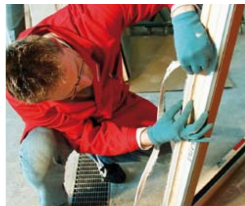
Dichtband aufkleben
