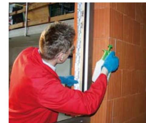
Befeuchtung des Mauerwerks vor dem Ausschäumen
