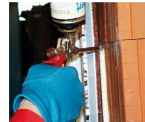
Anschlussfuge ausschäumen
